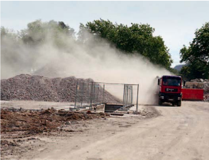
Abb. 1: Doppelbelastung aus mineralischem Staub und Rußpartikeln aus Dieselemissionen
